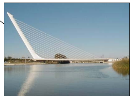
Puente del Alamillo
